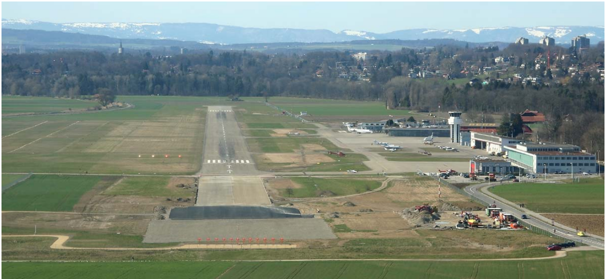
Abb. 3 Bauarbeiten zur Pistenverlängerung im Februar 2007
